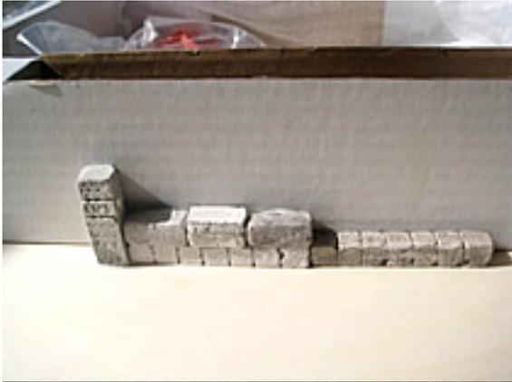
Damit Sie gerade hochmauern können, können Sie beispielsweise die Verpackungsschachtel verwenden. Stellen Sie diese direkt an das Mauerwerk.
